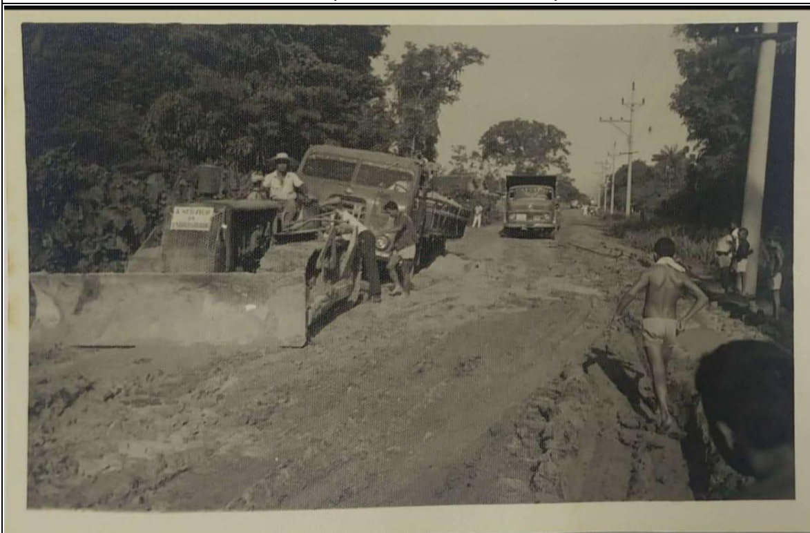
Foto 10 - Abertura da estrada nova para dar acesso ao Campus Guamá
