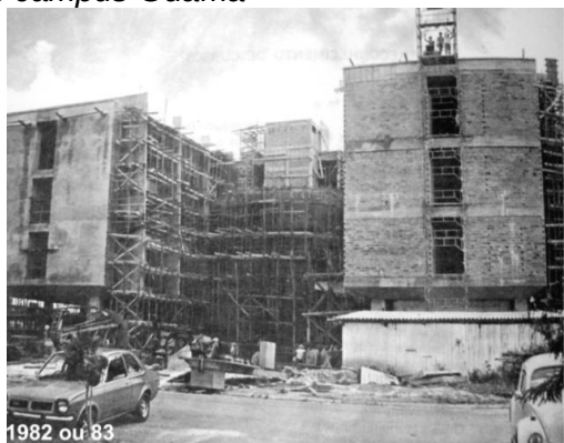
Foto 5 – Construção do Prédio da Reitoria no campus Guamá
