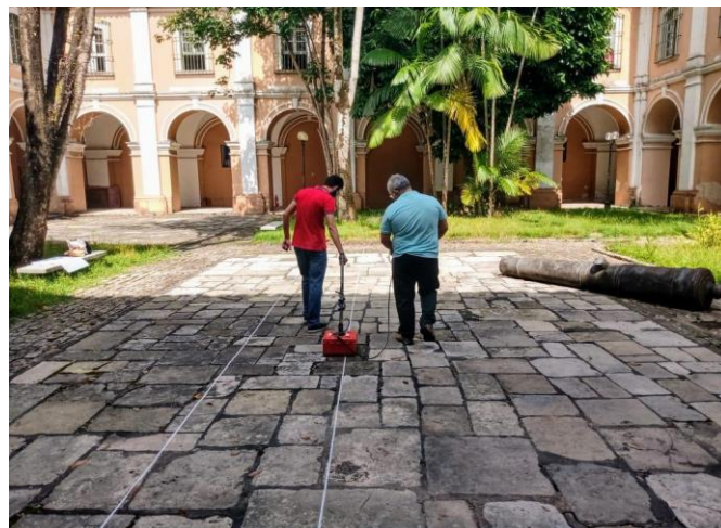
Figura 4.6 – Aquisição com o GPR realizado no Convento
