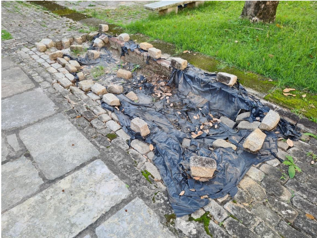
Figura 4.18 – Escavação iniciada no local indicado
