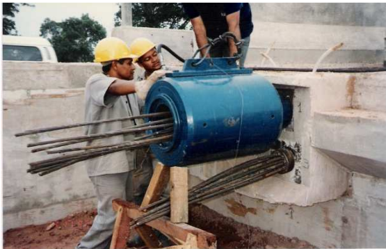
Figura 6 - Aplicação da protensão com macaco hidráulico. Fonte: Carneiro (2007).
