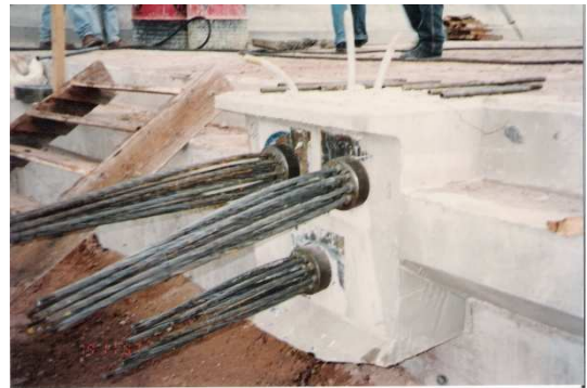
Figura 7 - Cabos e ancoragens. Fonte: Carneiro (2007).
