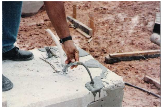
Figura 8 - Injeção da nata de cimento. Fonte: Carneiro (2007).
