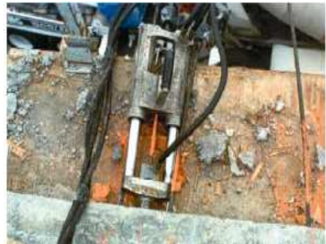
Figura 11 - Macaco de protensão de mono cordoalha. Fonte: Carneiro (2007).
