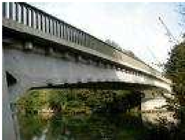
Figura 3 - Primeira ponte em concreto protendido. Fonte: sites.google.com/site/cissaat/história .
