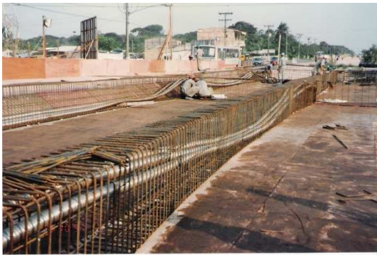
Figura 5 - Posicionamento das bainhas metálicas na viga. Fonte: Carneiro (2007).
