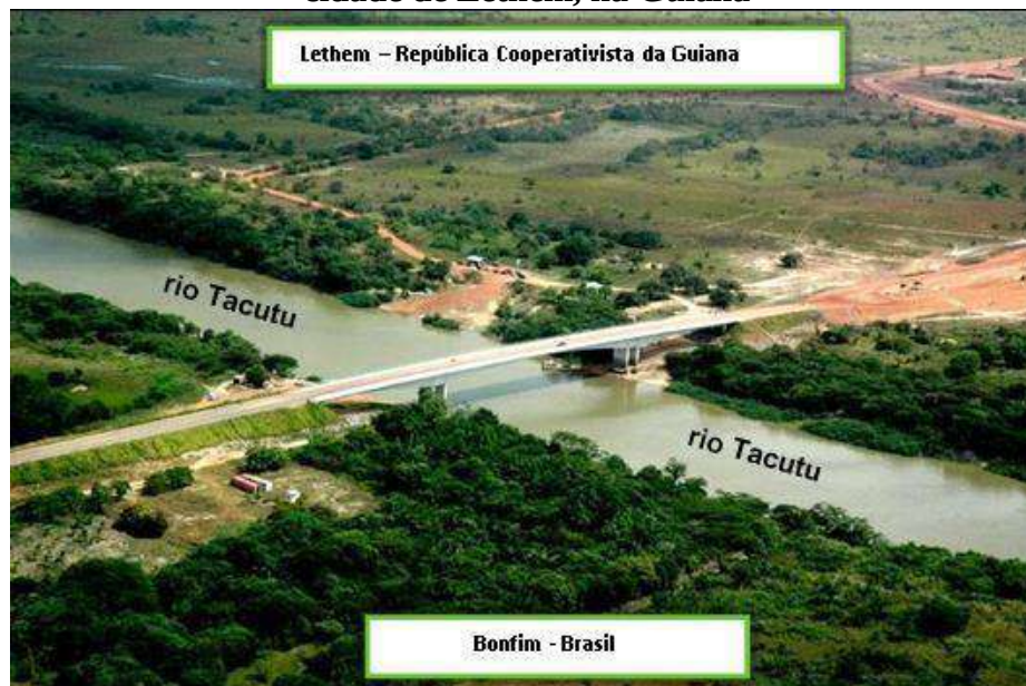
FIGURA 4: Imagem da ponte binacional Prefeito Olavo Brasil Filho sobre o rio Tacutu, que cruza o rio ligando a cidade brasileira de Bonfim, em Roraima, à cidade de Lethem, na Guiana
