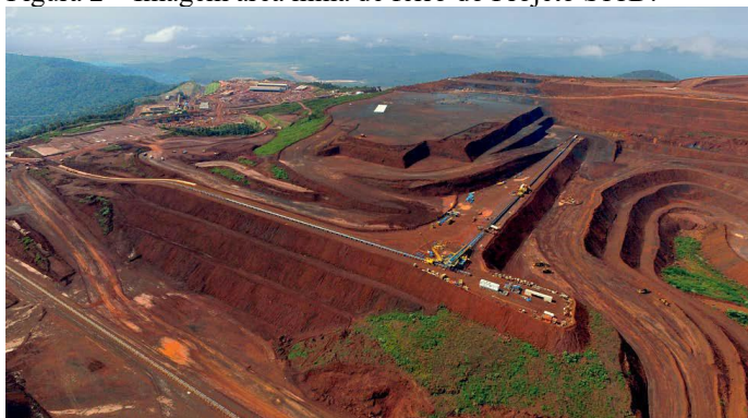
Figura 2 – Imagem área mina de ferro do Projeto S11D.
