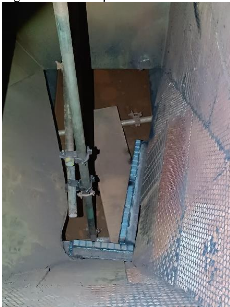
Figura 31 – Instalação do stone box
