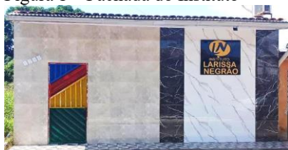
Figura 1 – Fachada do Instituto
