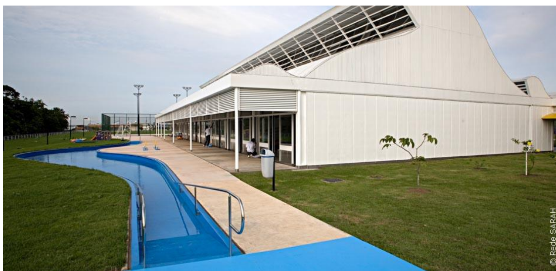
Figura 5: Centro de Reabilitação Pediátrica Sarah Belém (PA).
