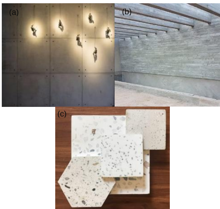
Figura 16: (a) Placa de concreto; (b) Ripas de concreto; (c) Amostras de placas de granilite.
