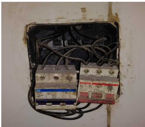
Figura 2.31 – Caixa de distribuição do setor produtivo em má condição.
