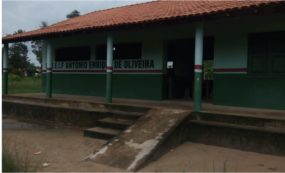
Foto 1: Fachada da Escola
