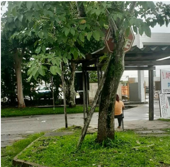
Figura 30 - Sinalização vertical quebrada
