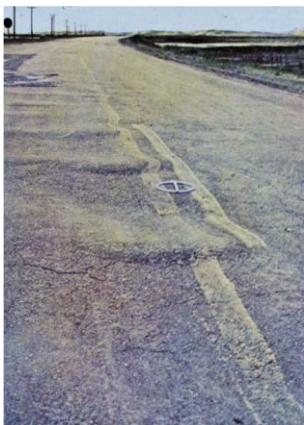
Figura A.7 - Ondulação ou Corrugação.
