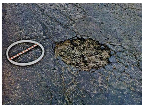
Figura A.10 - Panela ou buraco.
