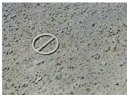
Figura A.9 – Desgaste.
