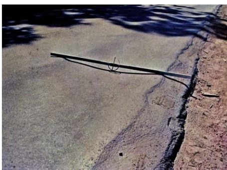
Figura A.5 - Afundamento plástico.
