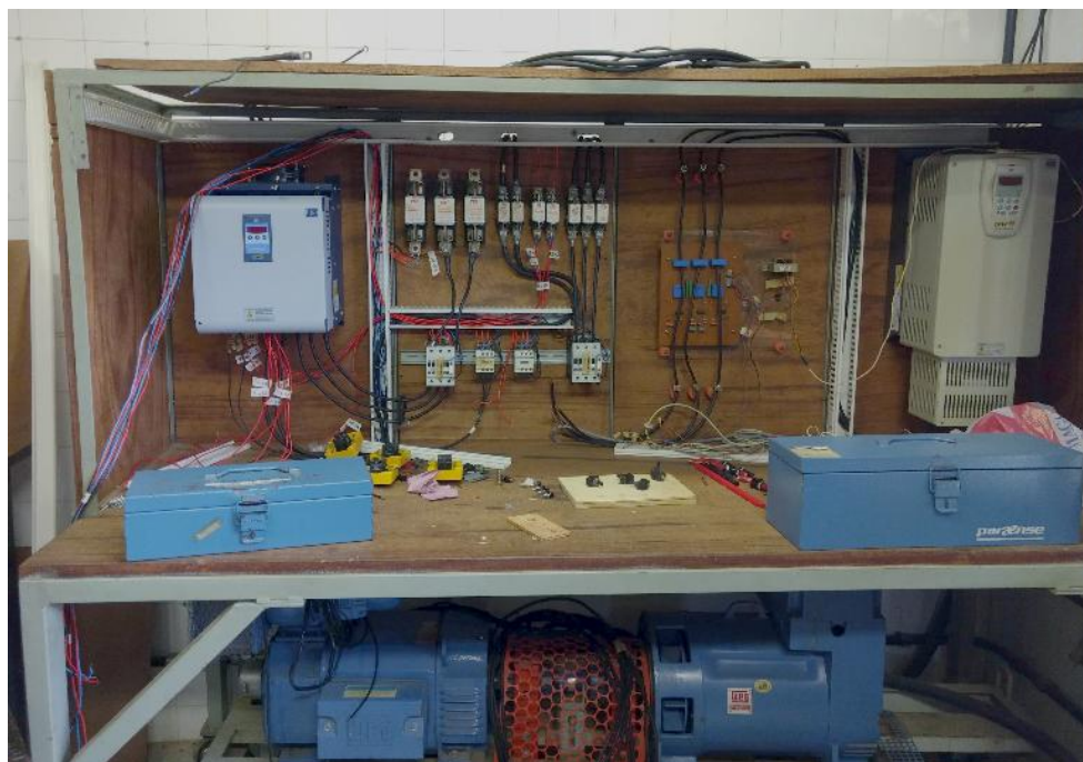
Figura 4 —Bancada Dinâmica parcialmente montada em nova configuração.
