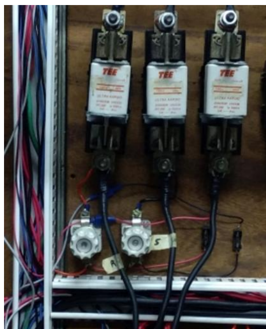
Figura 49 – (a) Foto do fusível Diazed ao lado da tampa de porta-fusível; (b) Foto do local de instalação dos porta-fusíveis Diazed na Bancada.
