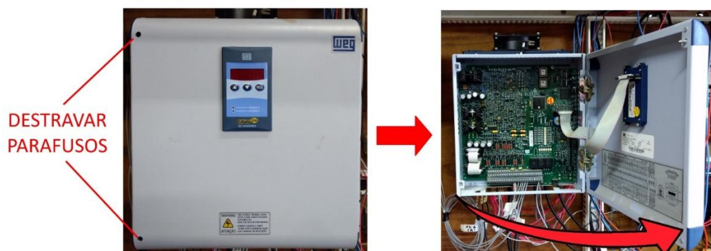
Figura 75 – Fotos e indicações do processo de abertura da tampa.
