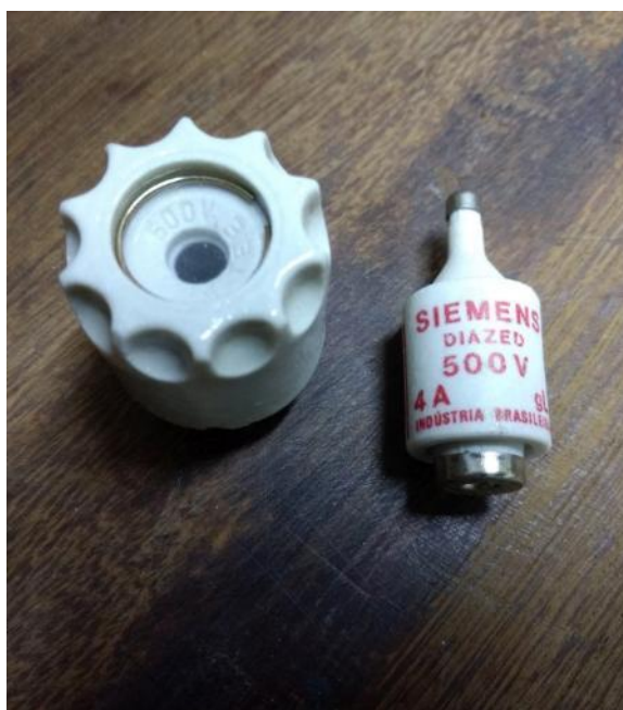
Figura 49 – (a) Foto do fusível Diazed ao lado da tampa de porta-fusível; (b) Foto do local de instalação dos porta-fusíveis Diazed na Bancada.
