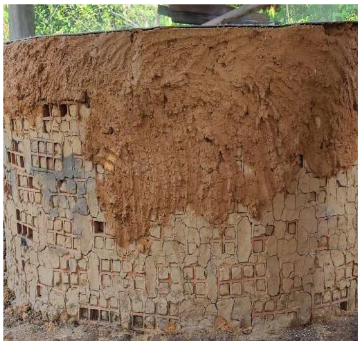
Figura 54 - Acabamento em reboco de barro na técnica de pau a pique
