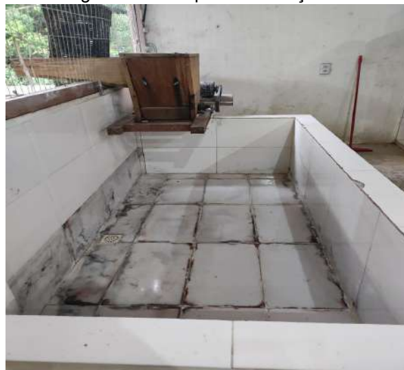
Figura 27 - Tanque de trituração
