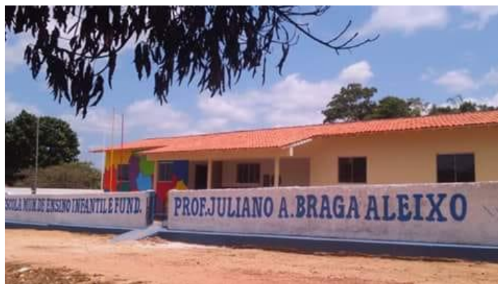
Foto 05: Frente da escola após reforma, 2015.
