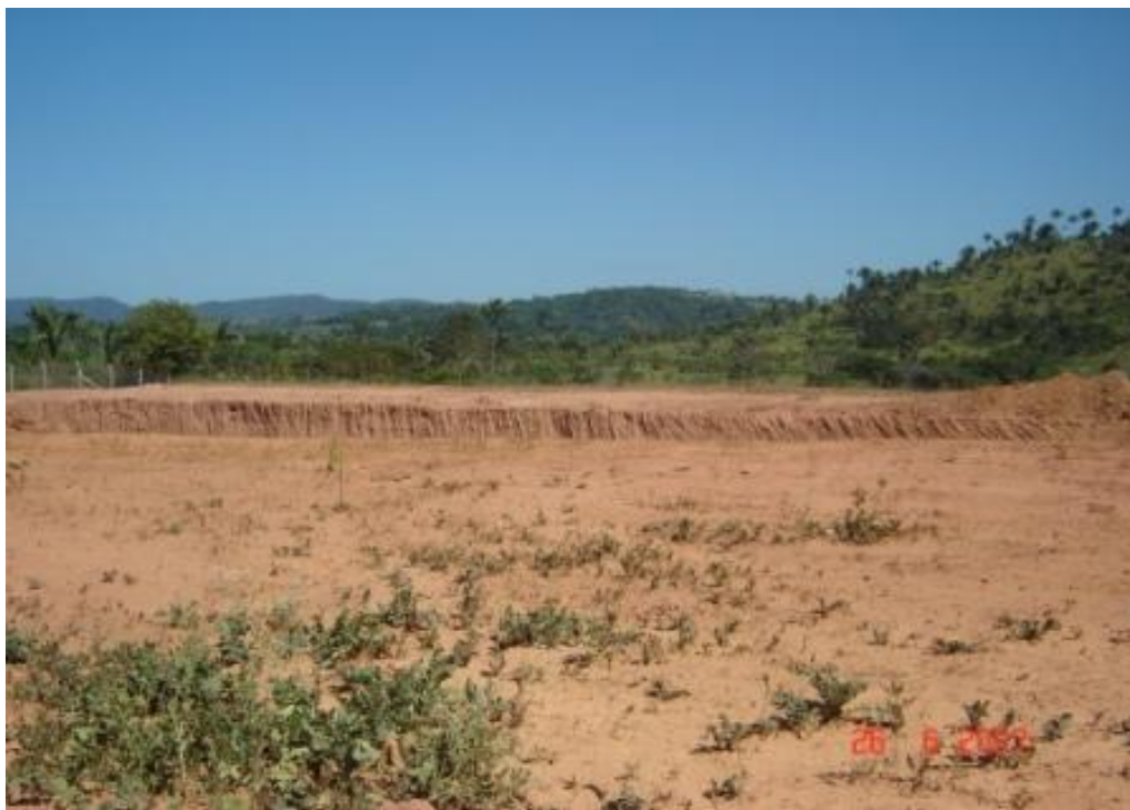
Fotografia 27 – Células destinadas para deposição do lixo. Fonte: Silva (2007).
