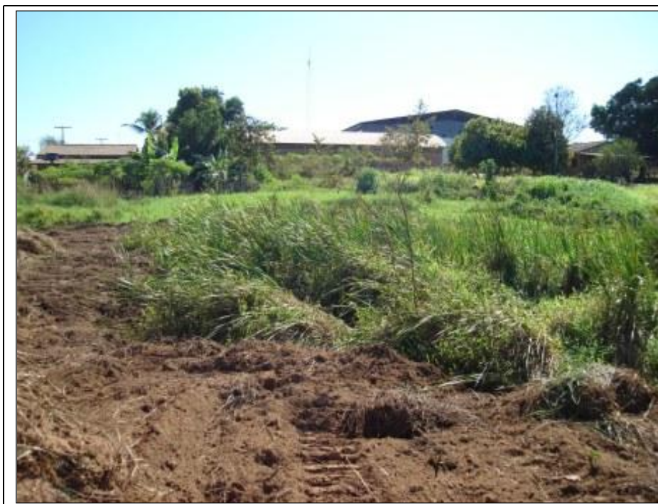
Fotografia 18 - Outra área em processo de aterramento Fonte: Silva (2007).
