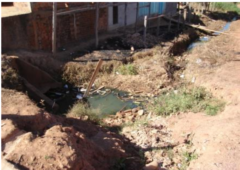
Fotografia 21 - Lançamento de esgoto diretamente no córrego.
