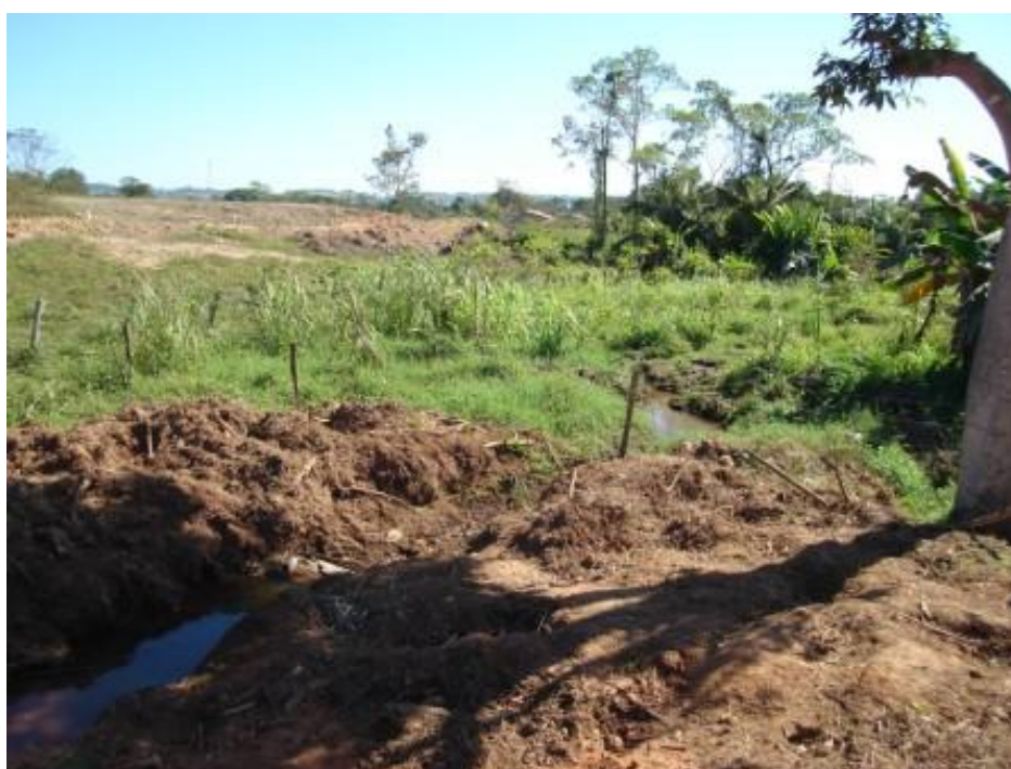
Fotografia 17 - Aterramento de áreas alagáveis no Município. Fonte: Silva (2007).
