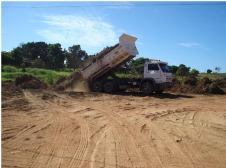
Fotografia 16 - Área alagável sendo aterrada. Fonte: Silva (2007).
