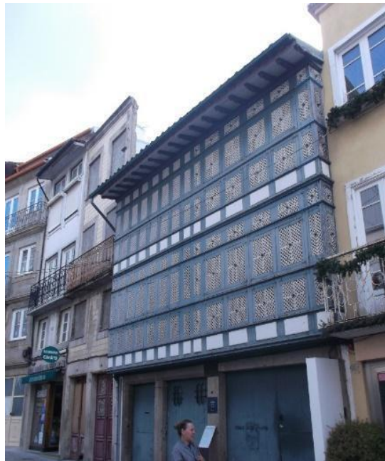
Figura 25: Edifício com fechamento em esquadrias de tipo gelosia, Braga, Portugal.
