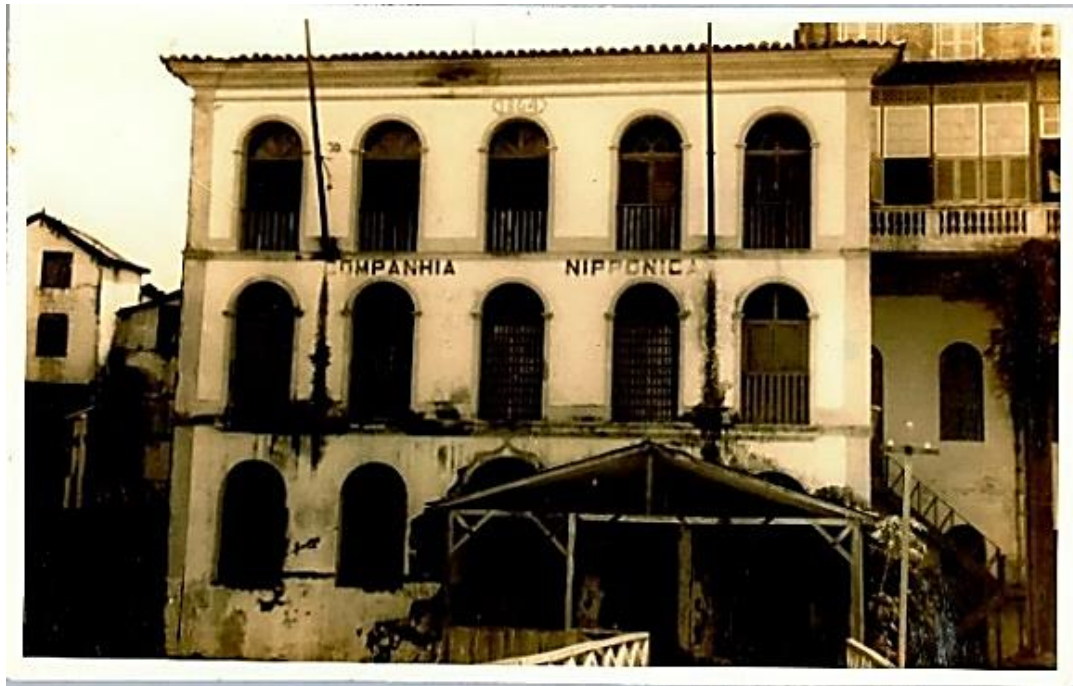
Figura 14: Fachada posterior voltada para a Baía do Guajará, cuja data sob a cornija “1864”. Fotografia P&B; 11,2 x 17,6 cm. Belém, Pará. 1940.
