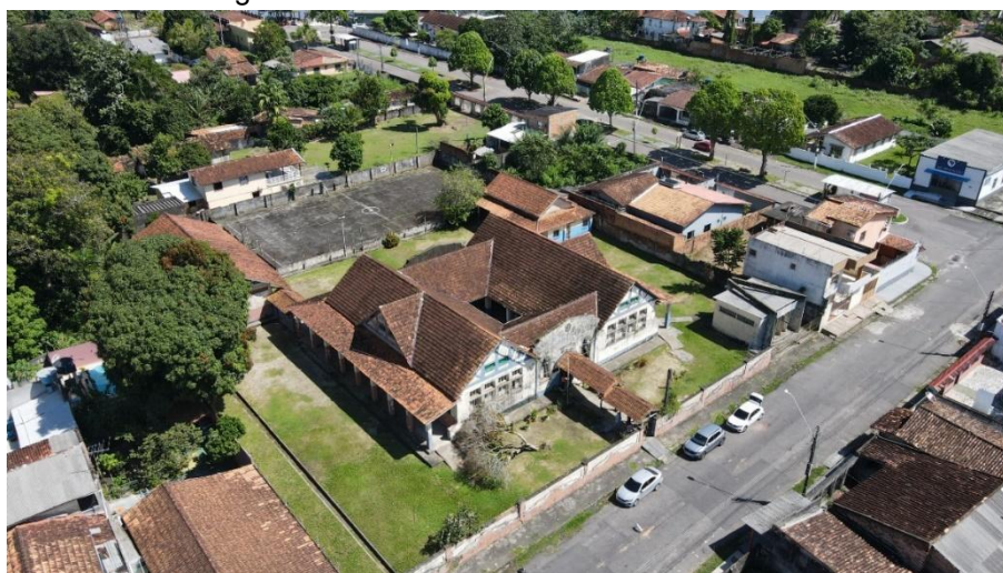
Figura 21 – Levantamento realizado via drone
