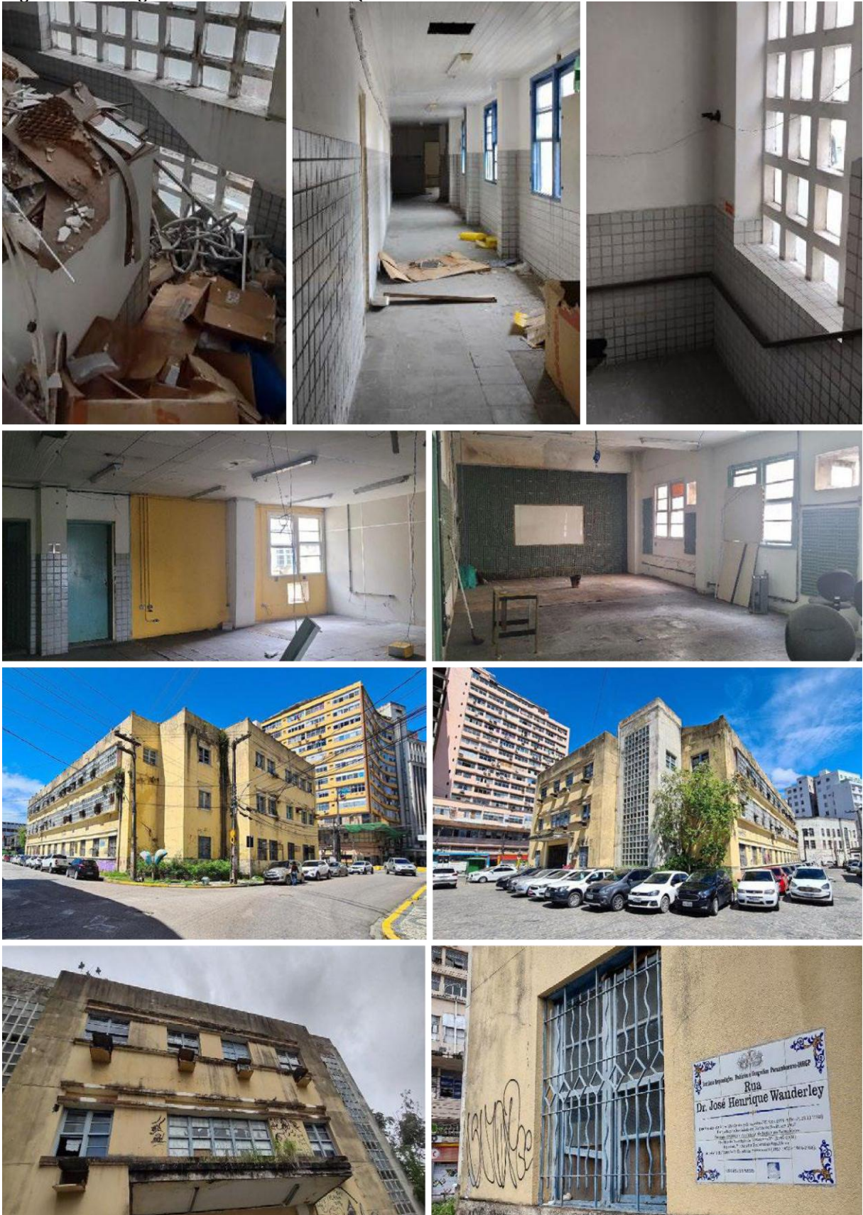
Figura 24 – Imagens do estado da edificação.
