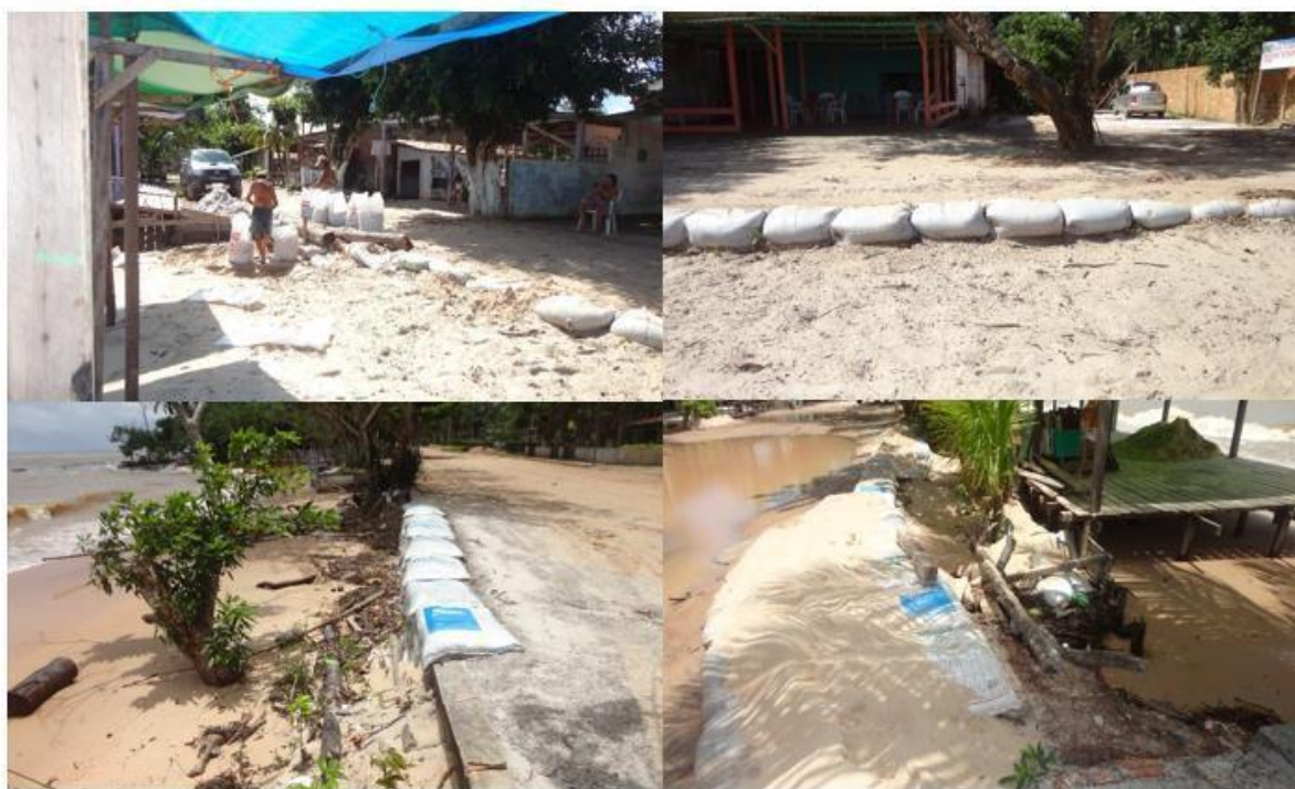
Figura 35-Exemplos de Rip-Rap implantados pela comunidade na praia de Marahú. Fotografia retirada em: 9/11/2016.
