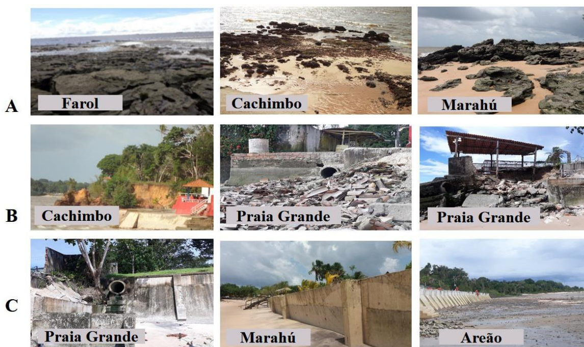
Figura 10- Indicadores de erosão evidentes na Ilha de Mosqueiro: (A) Depósitos pleistocênico e banco de cascalhos, (B) Desmoronamento de falésias, de muros e de casas, (C) Reconstrução de muros. Fotografias retiradas em: Abril/2017 à Junho/2019.
