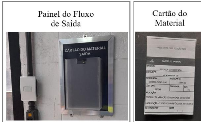
Figura 39 – Painel do Fluxo de Saída e Cartão do Material instalados.
