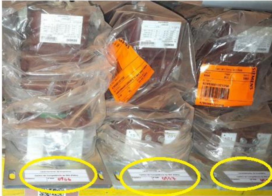
Figura 45 – Transformador de corrente com etiqueta de levantamento de inventário.
