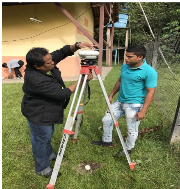
Figura 5 - Instalação da Base para coleta de dados
