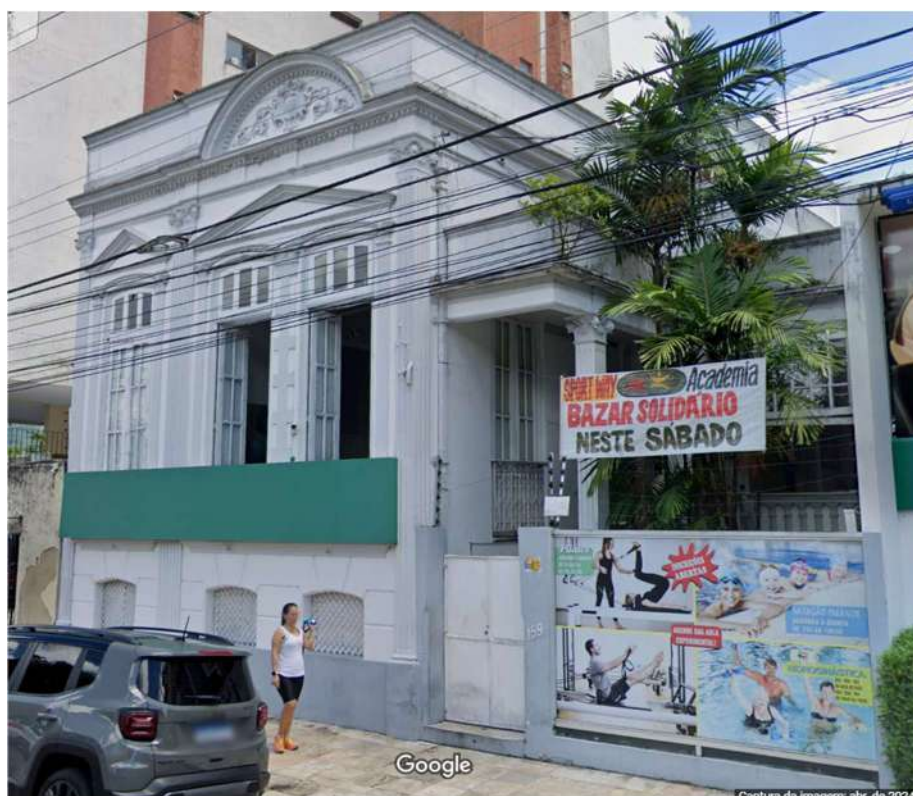
Figura 37 – Casa do século XX ainda existente próximo à praça Osvaldo Cruz
