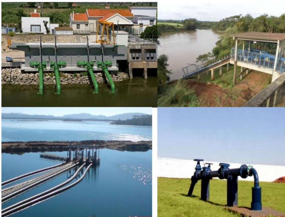
Figura 2 - Vista de várias estruturas de captação de água bruta
