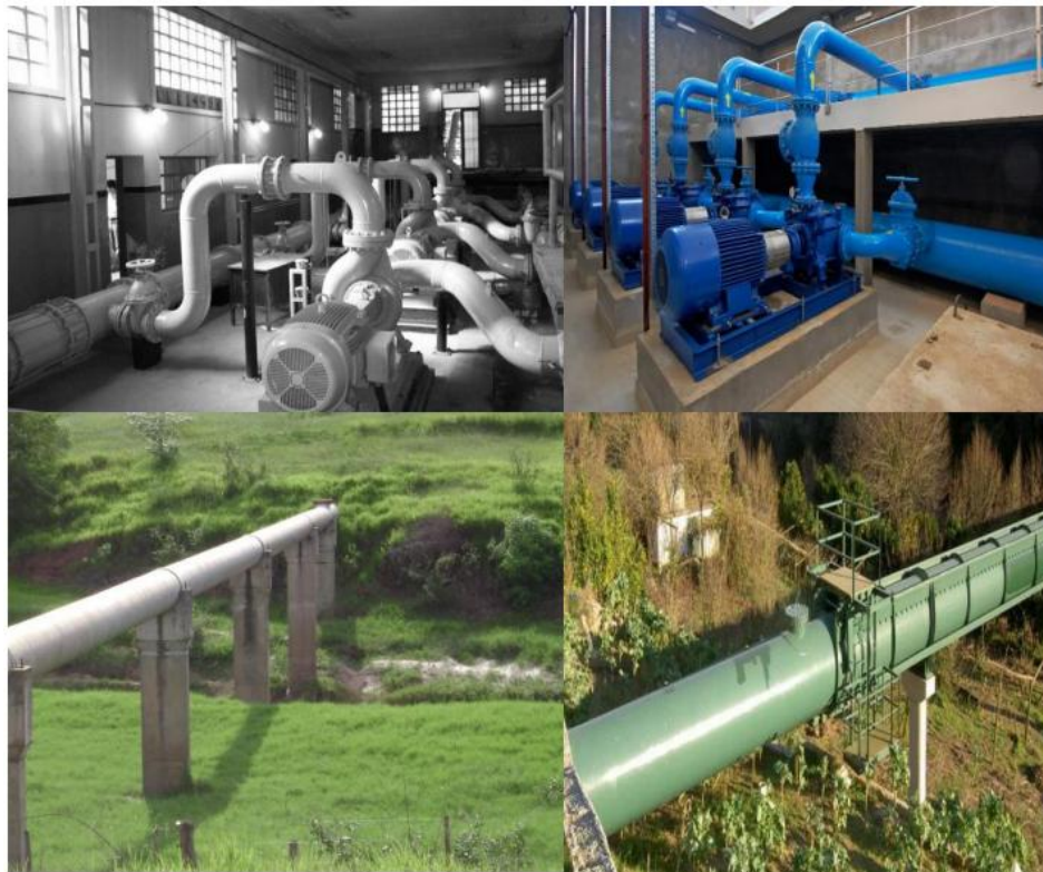
Figura 3 - Estações elevatórias de bombeamento e linhas adutoras
