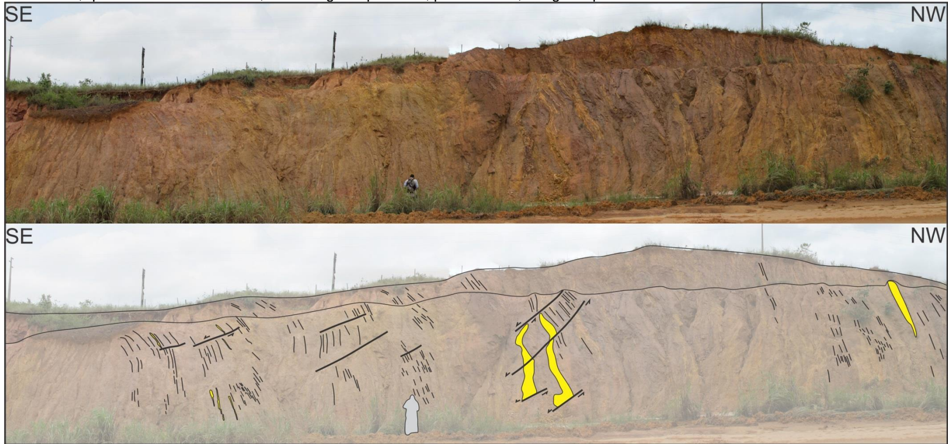
Figura 4.1 - Afloramento do tipo corte de estrada (Ponto 01), se observa a forma dos micaxistos e as estruturas que ocorrem: xistosidade, as falhas normais, e os veios de quartzo (em amarelo). Se nota que as falhas normais deslocam os veios de quartzo e modificaram a atitude da xistosidade, que deixou de ser NE-SW, com mergulho para NW, para NW-SE, mergulho para SW.
