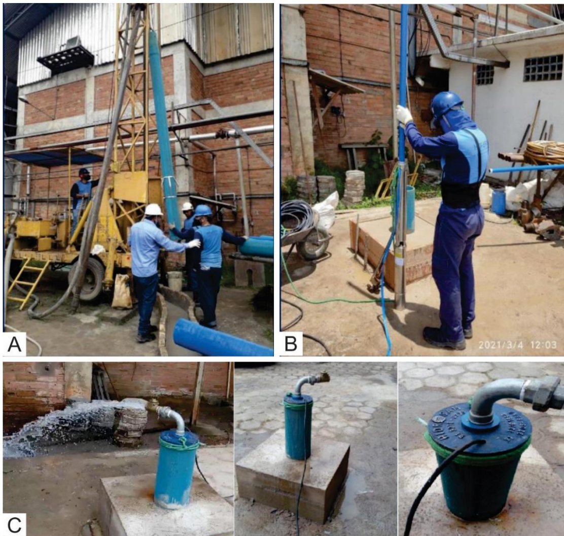
Figura A) Instalações finais da coluna construtiva do poço “Hidro A” em 2021, localizada na empresa EBATA localizada no distrito industrial de Icoaraci. B) Instalação de tubulação edutora final e bomba operacional. C) Condições finais de poço em operação.
