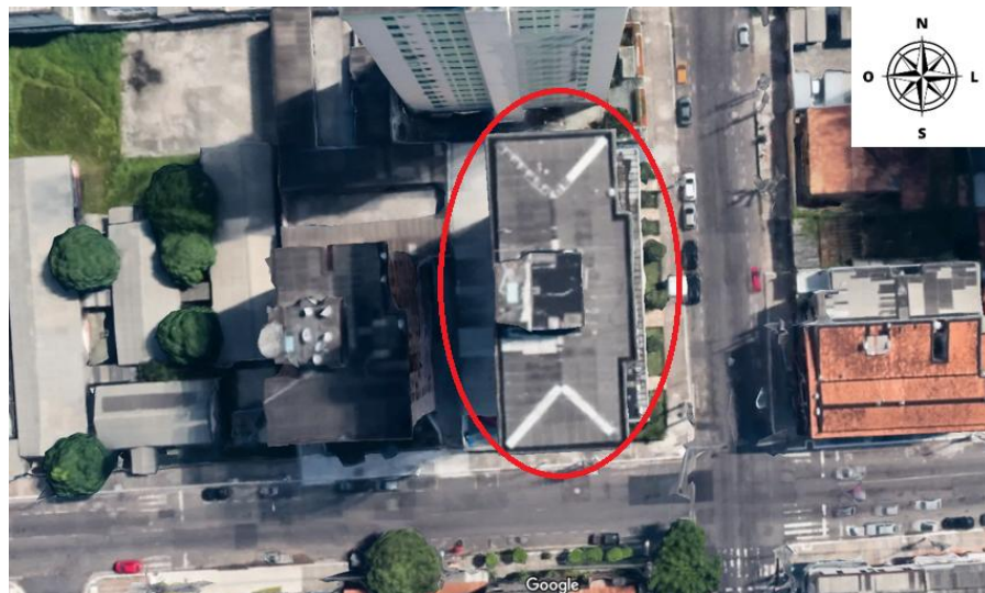
Figura 8. Localização por satélite do edifício na cidade de Belém-PA.
