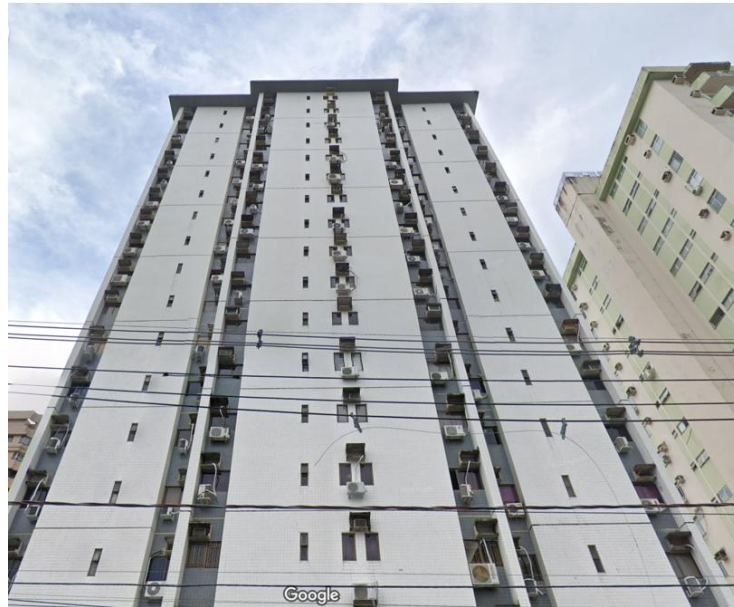
Figura 9. Fachada do edifício na cidade de Belém-PA.
