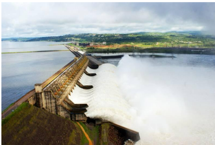
Figura 2 – Usina Hidrelétrica de Tucuruí, de (SOUSA, 2019).
