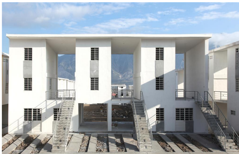
Figura 1 – Fachada da Habitação Monterrey.
