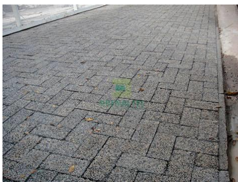
Figura 28 – Piso de concreto intertravado drenante
