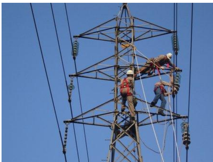
Figura 16 - Cadeias de isoladores sendo substituídas em linhas de transmissão
