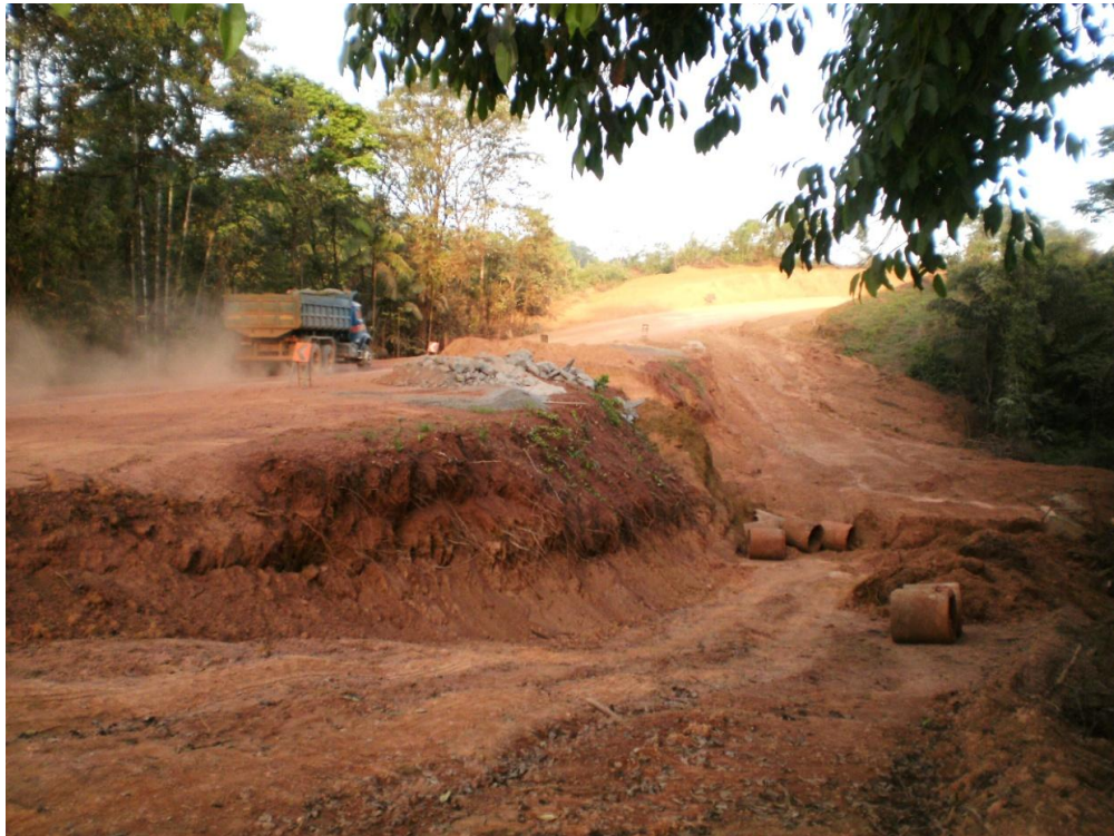
Figura 19 - Trecho entre Calçoene e Oiapoque, em viagem de campo realizada em 14/11/2011.
