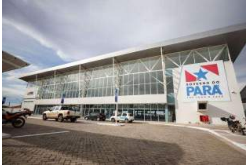
Figura 22: Terminal Hidroviário de Passageiros e Cargas de Santarém
