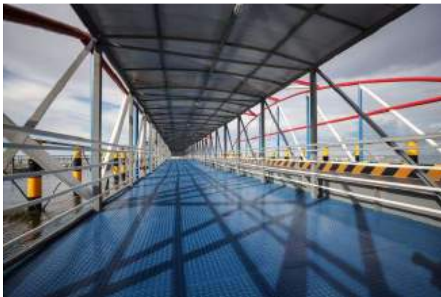
Figura 26: Rampa de embarque e desembarque do Terminal Hidroviário de Passageiros e Cargas de Santarém
