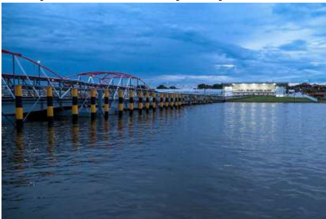
Figura 21: Terminal Hidroviário de Passageiros e Cargas de Santarém
