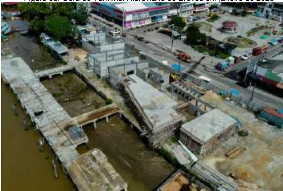
Figura 33: Obra do Terminal Hidroviário de Breves em janeiro de 2023
