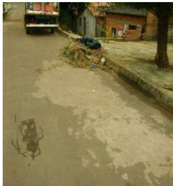
Figura 4.19B: Ala 07 – Presença de derrame de materiais.
