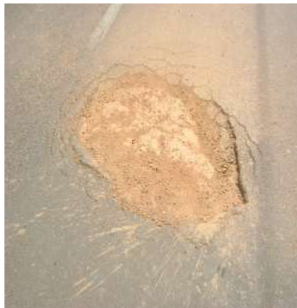
Figura 4.40A: Avenida W0 – Vista frontal do logradouro e presença de remendo. Figura 4.40B: Avenida W0 – Presença de panela.
