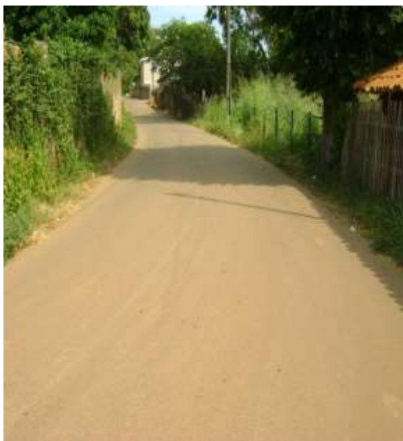
Figura 4.31A: Rua das Rosas – Vista frontal do logradouro.
