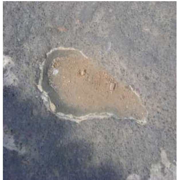
Figura 4.23A: Ala 11 – Presença de derrame de materiais. Figura 4.23B: Ala 11 – Presença de panela.
