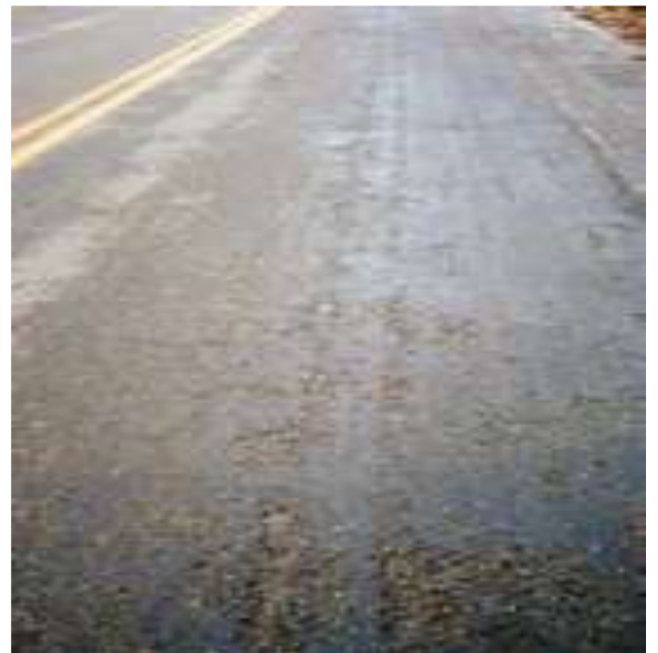
Figura 2.6D: Desgaste de capa. Fonte: Bernucci et.al. (2008).
