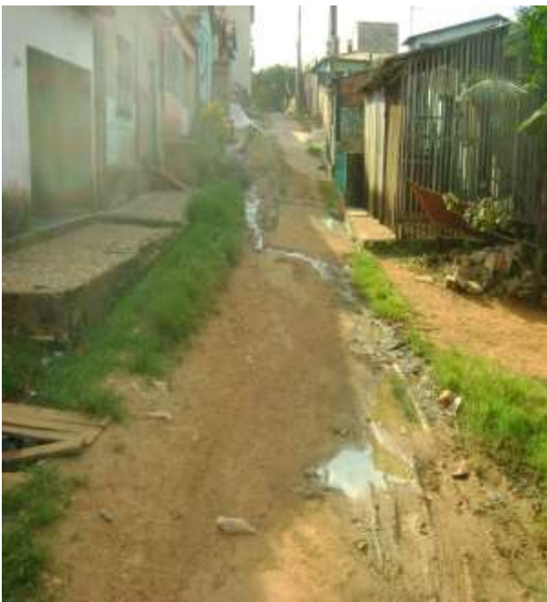
Figura 4.12C: Rua Fortaleza – Vista frontal no final do logradouro.
