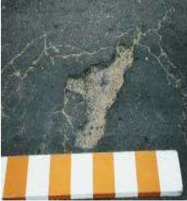
Figura 2.5A: Panela (Buraco). Fonte: Danieleski (2004).
