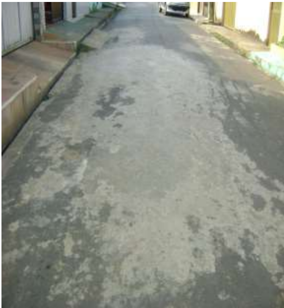
Figura 4.23A: Ala 11 – Presença de derrame de materiais. Figura 4.23B: Ala 11 – Presença de panela.
