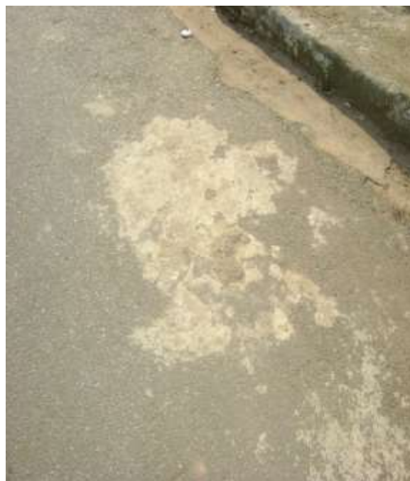
Figura 4.30B: Rua dos Jasmins – Presença de derrame de materiais.
