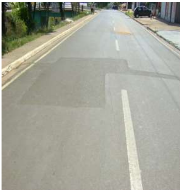
Figura 4.40A: Avenida W0 – Vista frontal do logradouro e presença de remendo. Figura 4.40B: Avenida W0 – Presença de panela.
