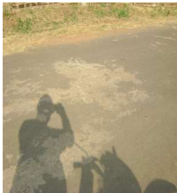
Figura 4.27B: Ala E7 – Presença de derrame de materiais.
