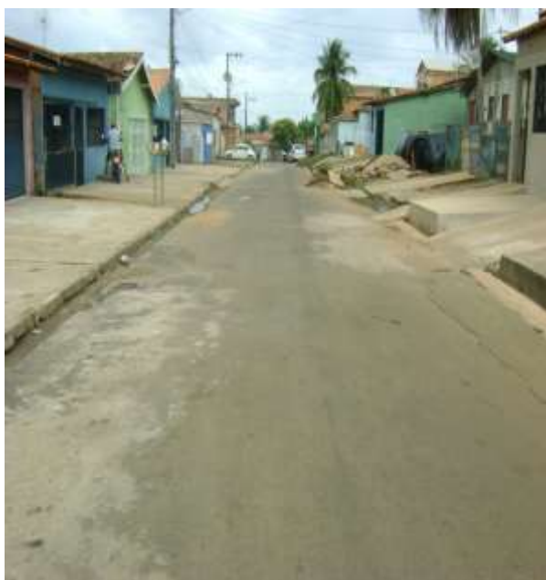
Figura 4.16A: Ala 04 – Presença de derrame de materiais.
