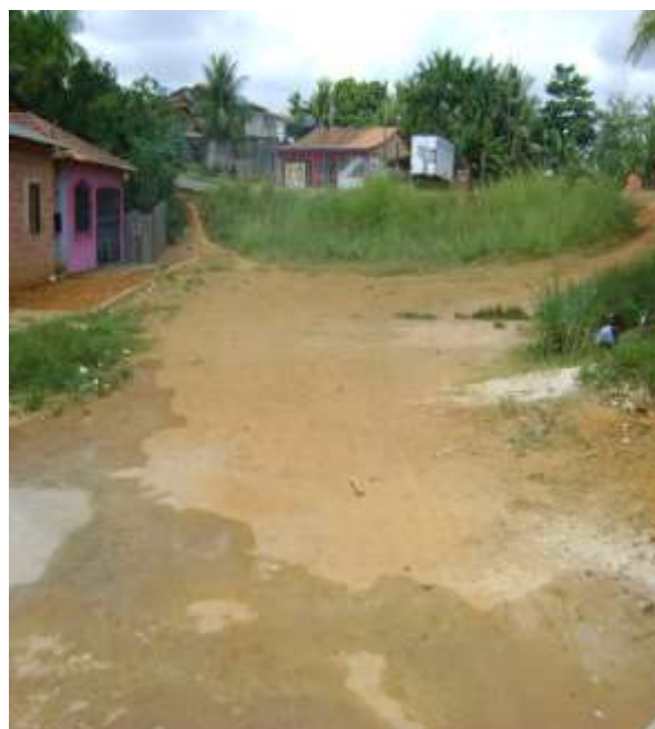
Figura 4.39B: Travessa Alto Alegre – Vista frontal no final do logradouro e ausência de revestimento asfáltico.
