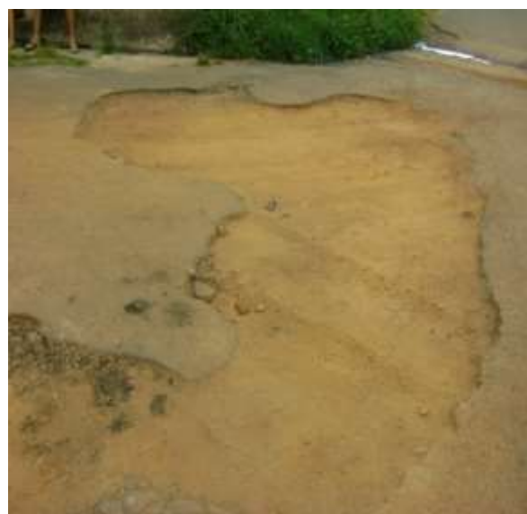
Figura 4.35B: Travessa W2 – Presença de panela.
