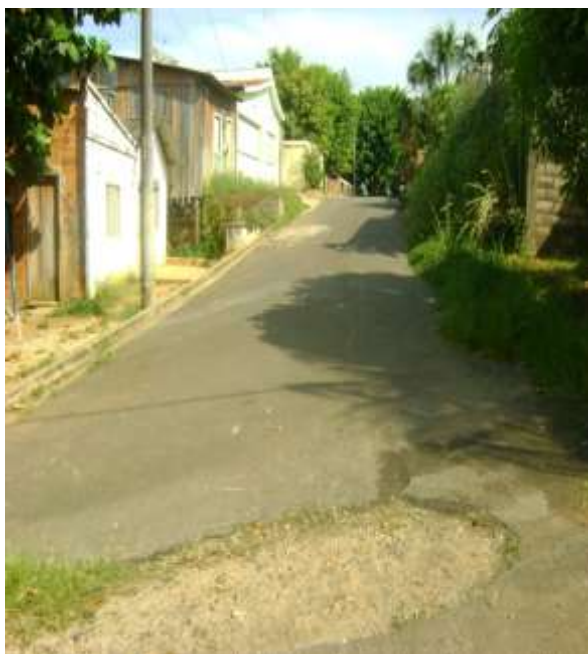
Figura 4.21A: Ala 09 – Vista frontal no início do logradouro e presença de derrame de materiais.
