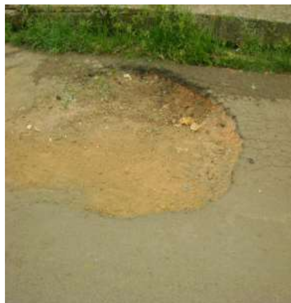
Figura 4.15A: Ala 03 – Presença de derrame de materiais. Figura 4.15B: Ala 03 – Presença de panela.
