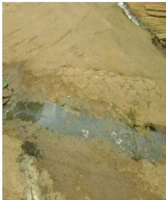
Figura 4.38B: Travessa W9 – Presença de panela na via.
