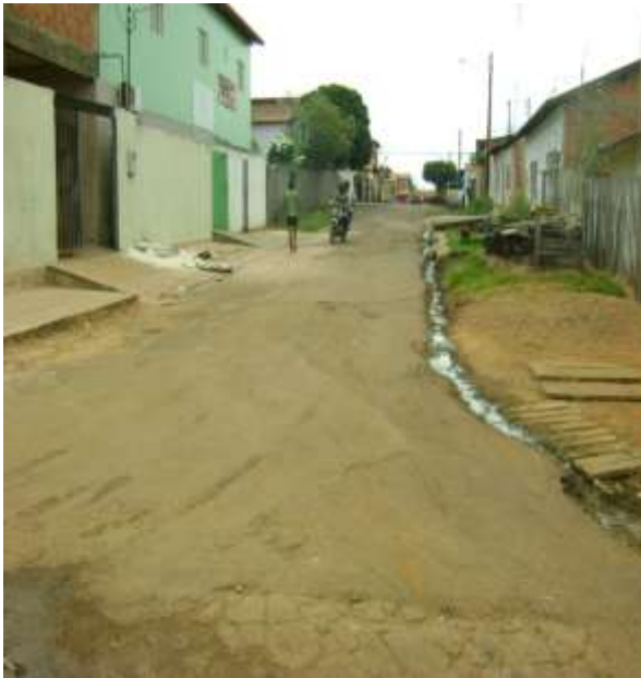
Figura 4.17A: Ala 05 – Vista frontal e presença de trincas de reflexão.
