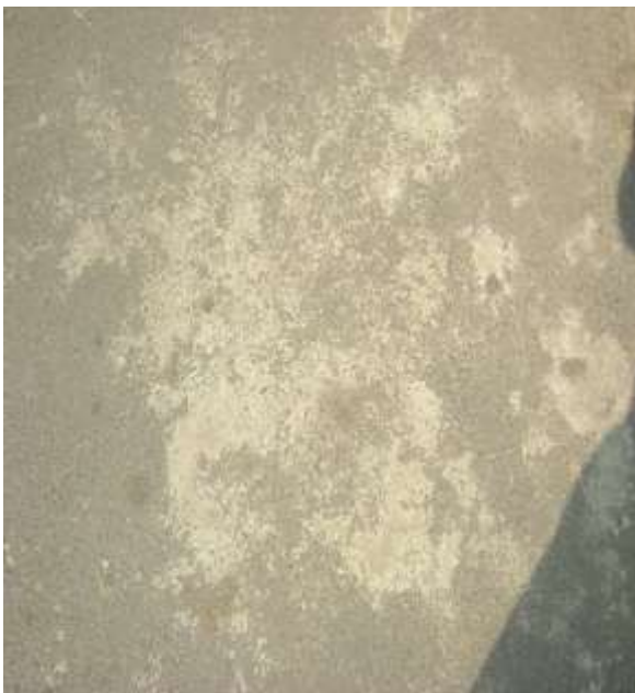
Figura 4.25A: Ala 14 – Presença de derrame de materiais. Figura 4.25B: Ala 14 – Presença de panela.
