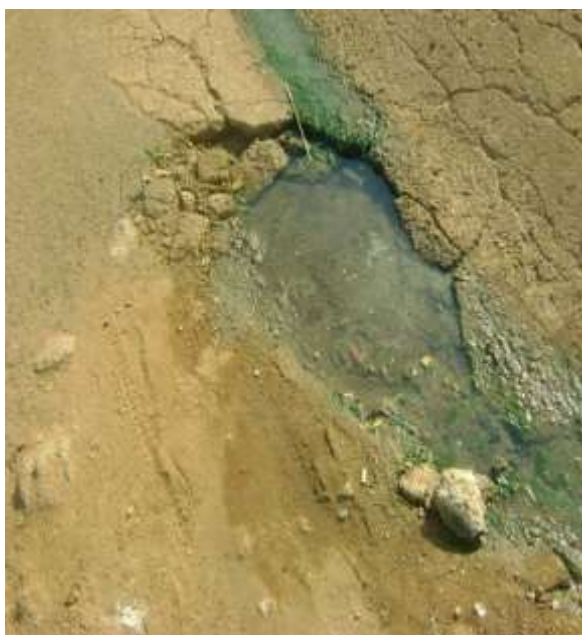
Figura 4.41A: Avenida Sete de Setembro – Presença de panela.
