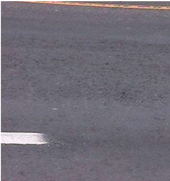
Figura 2.7C: Segregação. Disponível em:< http://www.ebah.com.br/content/ABAAABBRgAE/defeitos-pavimentos >. Acesso em: 13 março 2012.
