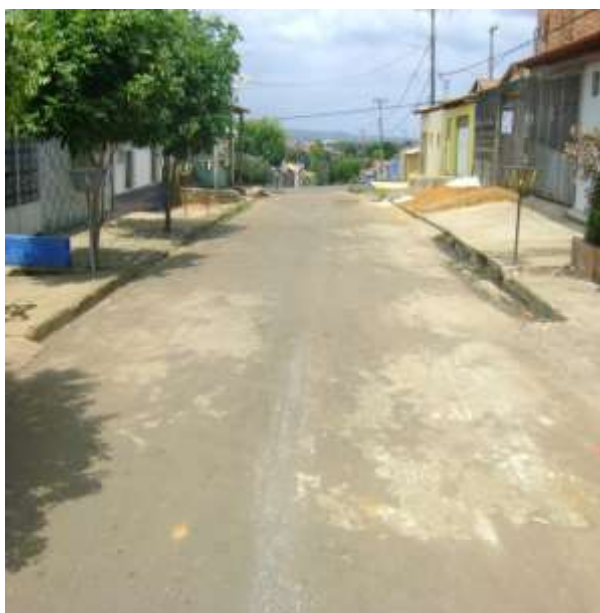
Figura 4.15A: Ala 03 – Presença de derrame de materiais. Figura 4.15B: Ala 03 – Presença de panela.
