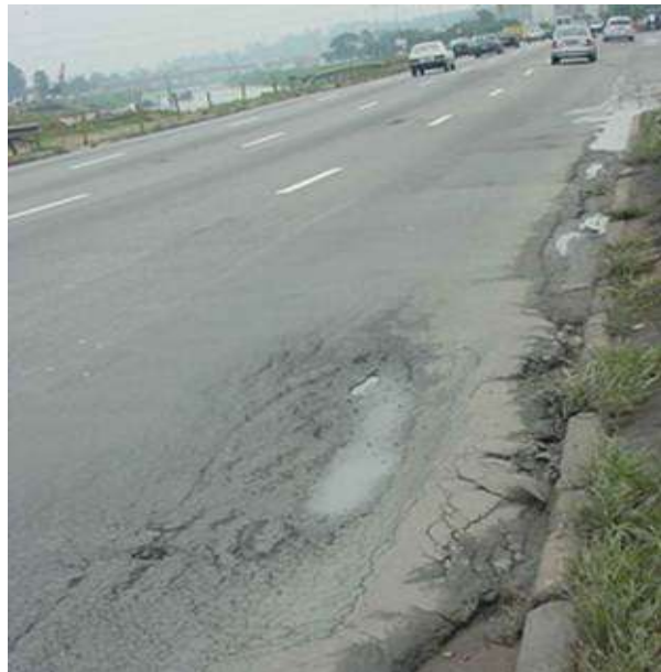
Figura 2.7D: Afundamento Local Plástico. Disponível em:< http://www.ebah.com.br/content/ABAAABBRgAE/defeitos-pavimentos >. Acesso em: 13 março 2012.
