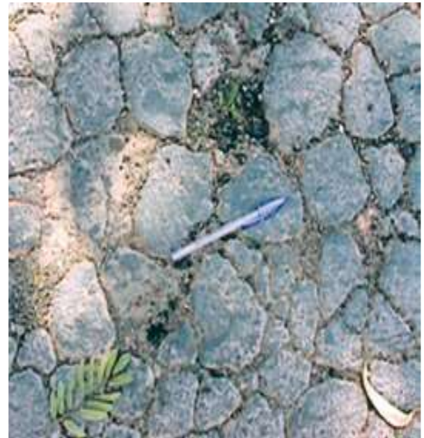
Figura 2.5D: Trincamento com severidade alta (couro de jacaré). Fonte: Bernucci et.al. (2008).
