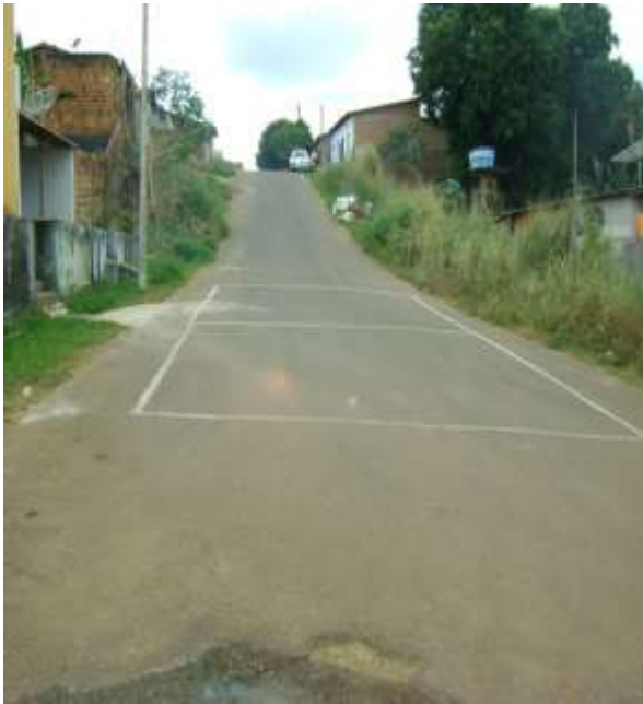
Figura 4.20A: Ala 08 – Vista frontal no final do logradouro e presença de panela.
