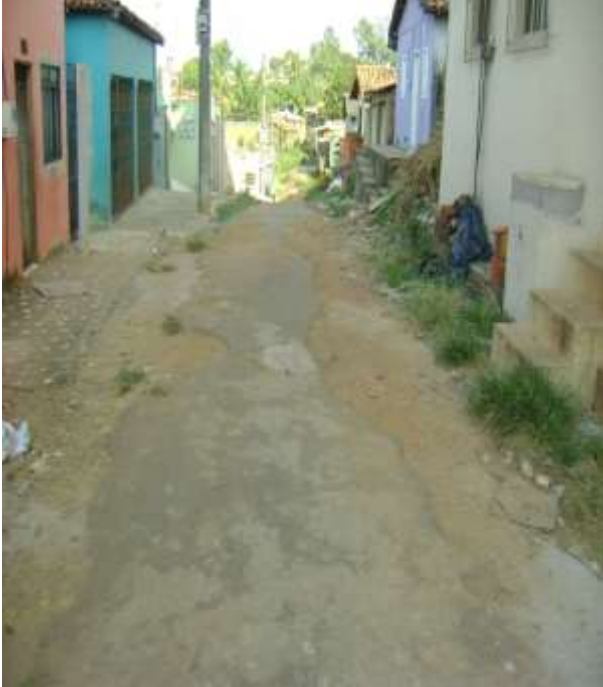
Figura 4.12A: Rua Fortaleza – Vista frontal no início do logradouro.
