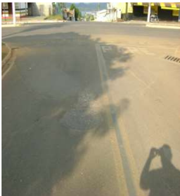
Figura 4.27A: Ala E7 – Presença de remendos de intervenção.
