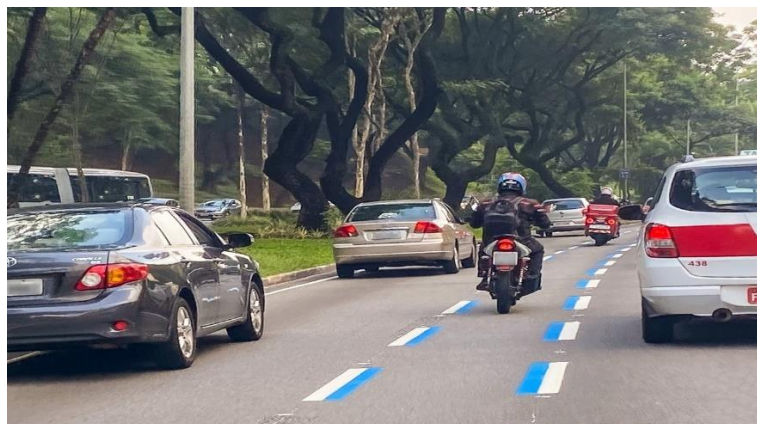
Figura 3 - Faixa azul exclusiva para motos na Av. 23 de Maio, instalada em janeiro de 2022 — Foto: Celso Tavares/g1. Fonte: G1.
