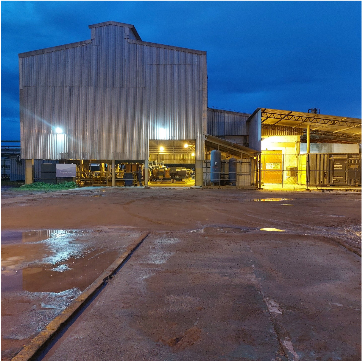
Figura 3.3: Setor de bombeamento da polpa tratada.
