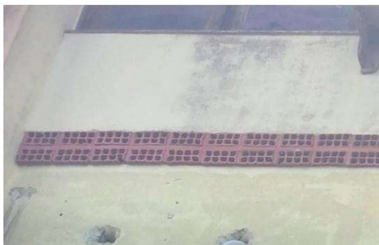
Figura 21– Detalhe arquitetônico, tijolo de cerâmica vazado, Bloco do Ensino Médio.
