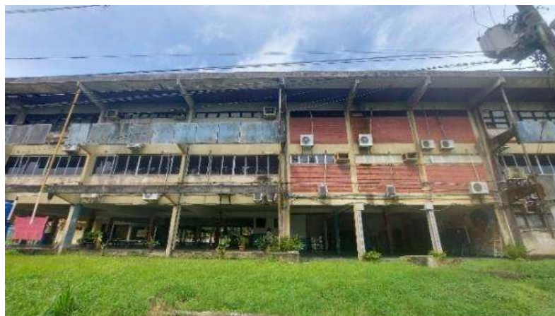
Figura 20 – Fachada lateral do Bloco do Ensino Médio.
