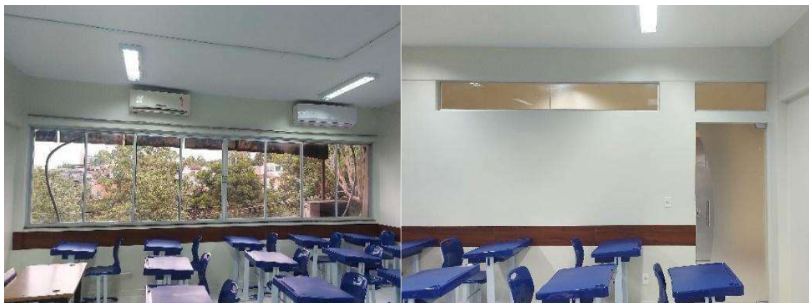
Figura 16 – Foto da sala de aula do Ensino Médio da EA-UFGA, mostrando as esquadrias e a vedação com vidro e metal.
