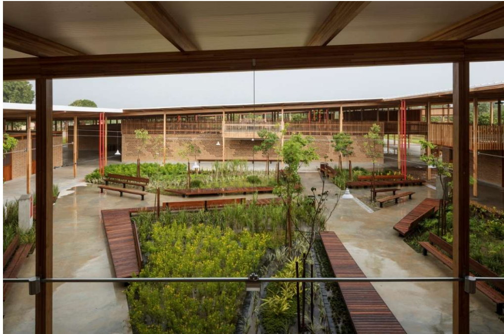
Figura 29 - Pátio interno que configura o espaço de transição entre interior e exterior das moradas.
