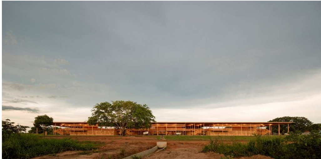
Figura 30 - Projeto visto de longe destacando sua integração com o ambiente ao redor.
