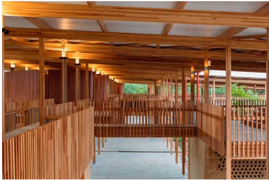
Figura 27 - Materiais utilizados na escola como o Tijolo solo-cimento e a madeira laminada.
