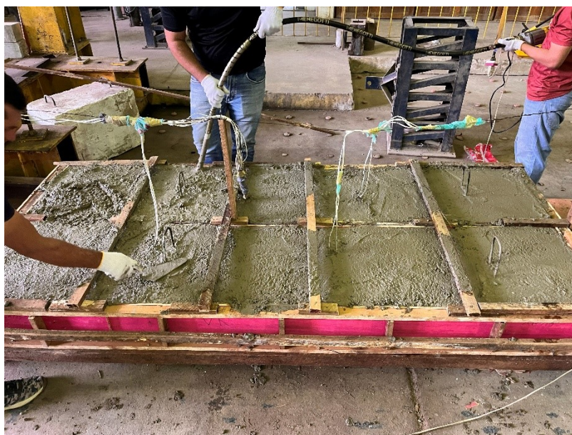
Figura 17 – concretagem das vigas.
