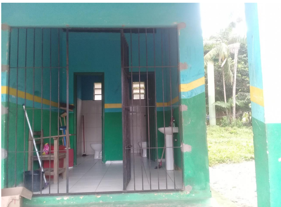
Fig. 07: Banheiros da Escola Municipal de Educação Infantil e Ensino Fundamental do Cumaru Fonte: Arquivo pessoal do autor
