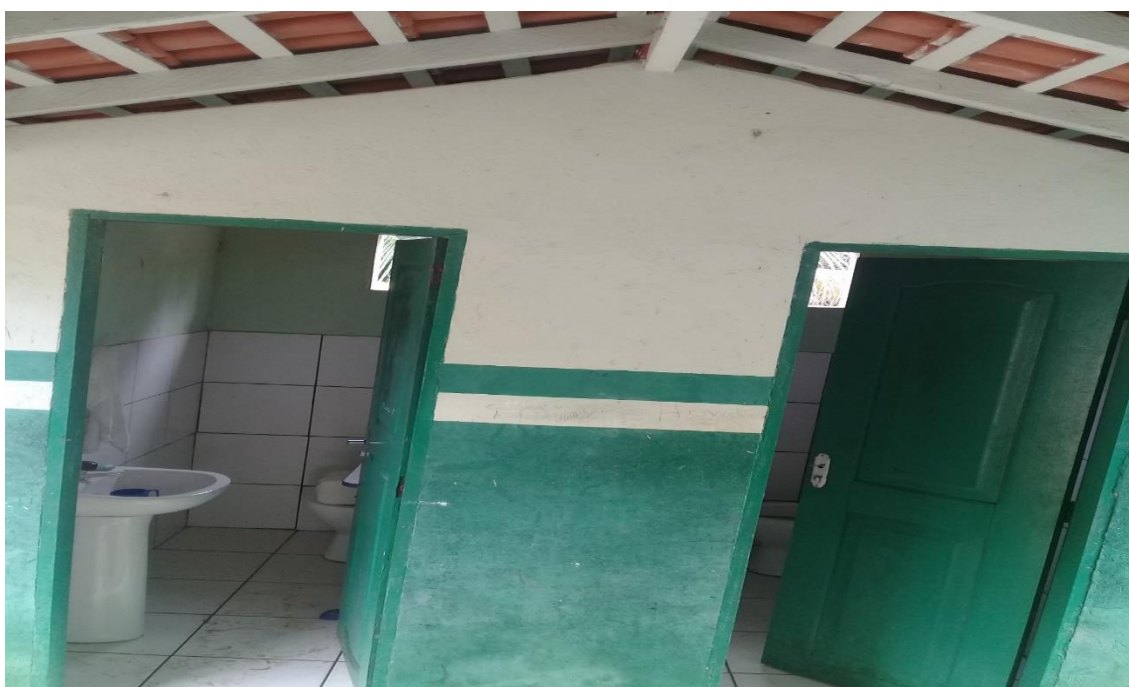
Fig. 04: Banheiros da Escola Municipal de Educação Infantil e Ensino Fundamental de Maracanã Fonte: Arquivo pessoal do autor
