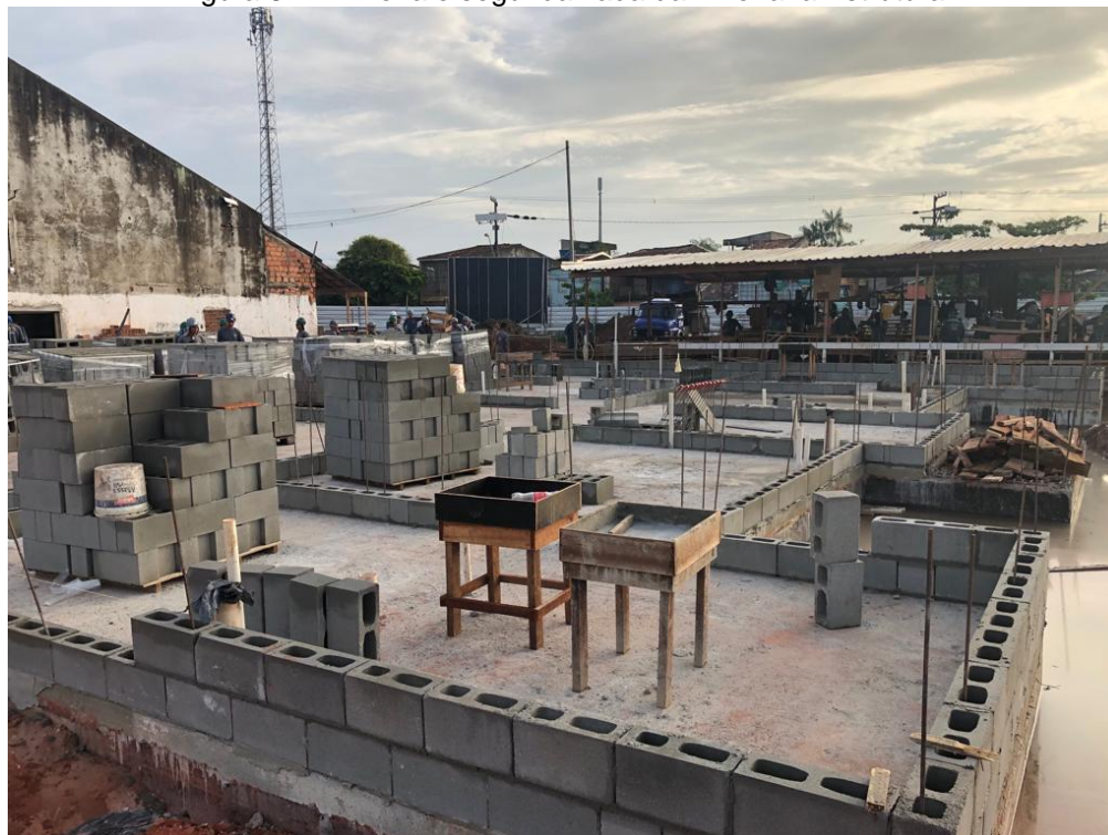
Figura 8 – Primeira e segunda fiada da Alvenaria Estrutural
