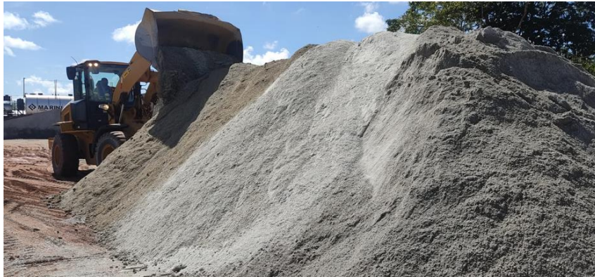
Figura 11 - Pilha de agregados miúdos de pó de pedra.
