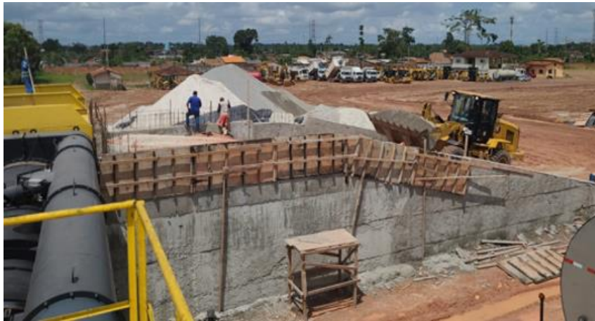
Figura 13 - Visão geral da usina Norte Ambiental Gestão e Serviços LTDA.
