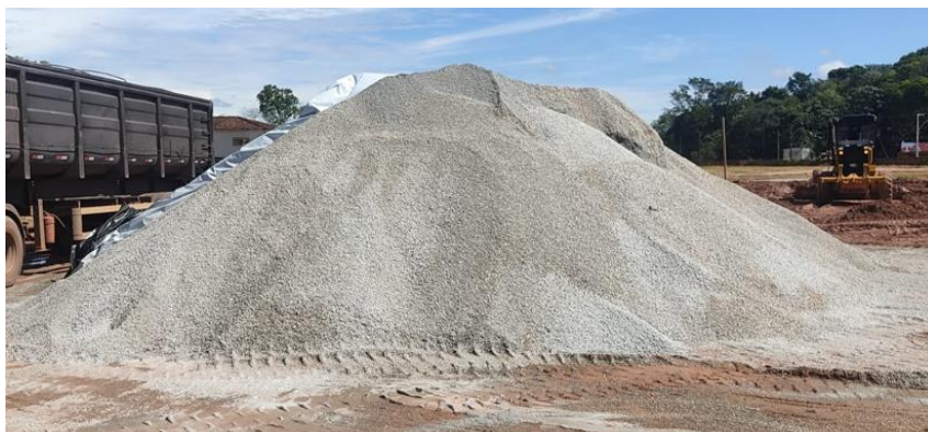
Figura 10 - Pilha de agregados graúdos de brita 0.
