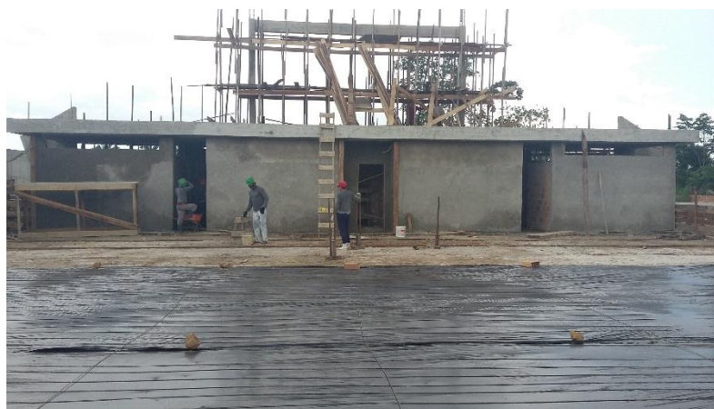
Figura 5– Ginásio em construção
