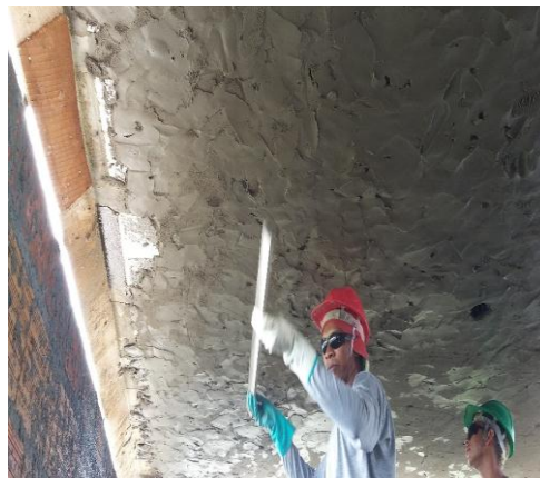
Figura 8- Sarrafiamento com a régua de pedreiro
