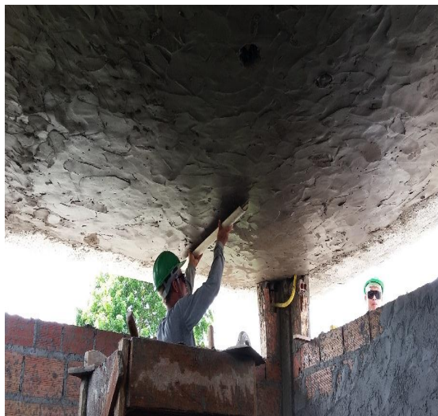
Figura 12- Sarrafiamento com tubo hidráulico
