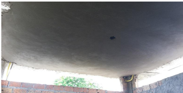
Figura 14- Teto sarrafiado com o tubo PVC
