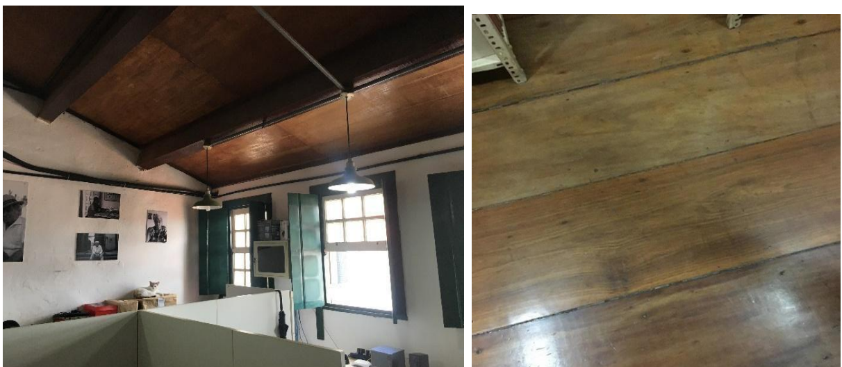
Figura 08 – Teto, vigas e piso em madeira (Casa de Jorge Amado)
