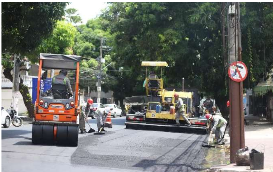
Figura 15 - Obra na Av. Gentil Bittencourt
