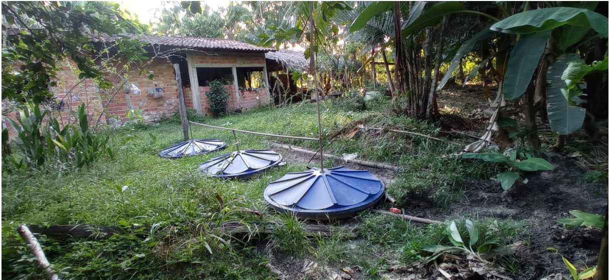
Figura 14 - Fossa séptica biodigestor
