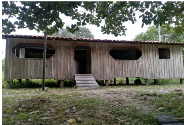
FIGURA 01: Aspecto externo da E. M. E. F. Perpétuo Socorro (ALTO MOJU/PA).
