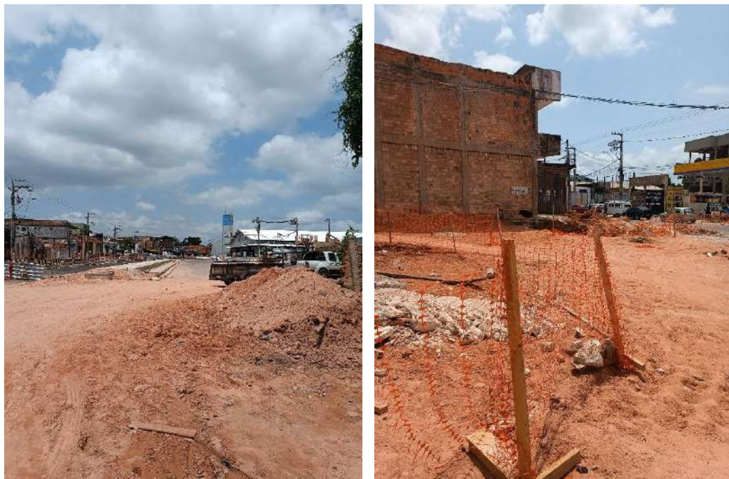
FIGURA 21 A e B – OBRA NO TRECHO DE ESTUDO
