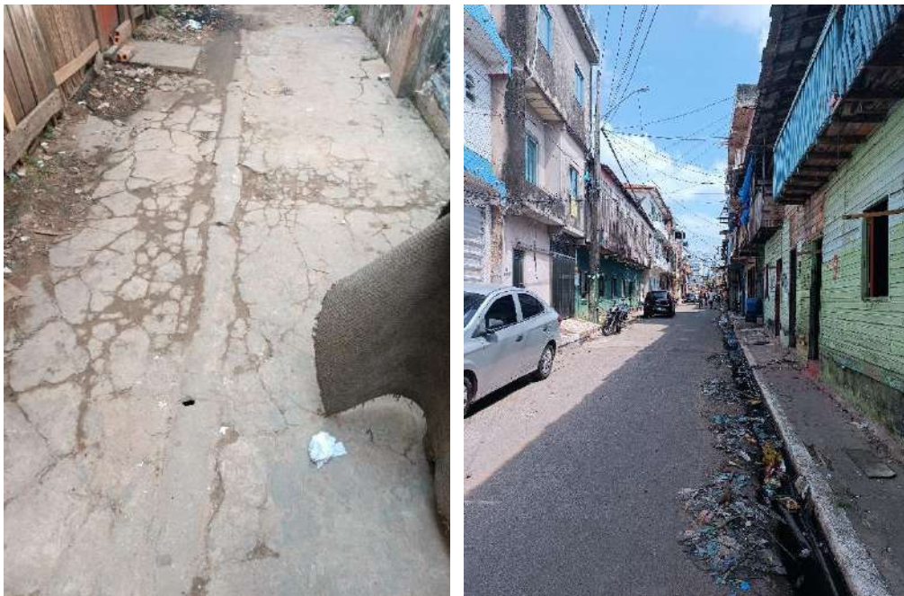
FIGURA 25 e 26 – SISTEMA DE DRENAGEM E ESGOTO IMPROVISADOS
