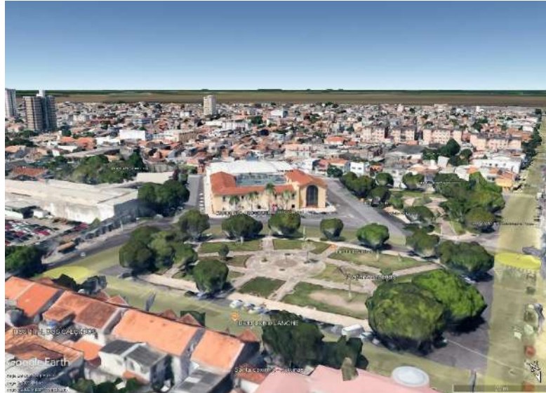
FIGURA 47 – PRAÇA AMAZONAS, DENTRO E FORA DO BAIRRO DO JURUNAS
