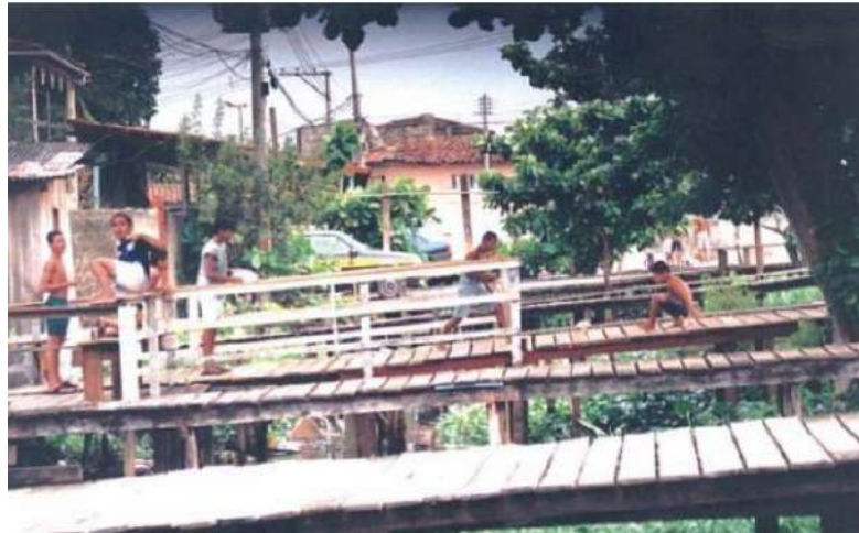
FIGURA 27 – PONTES NAS ÁREAS ALAGADAS
