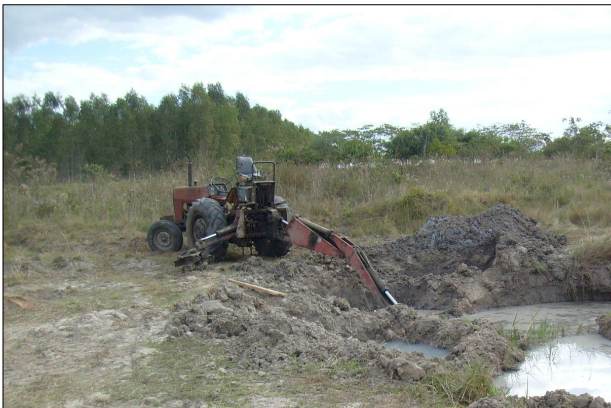
Figura 10 - Retroescavadeira de pequeno porte.
