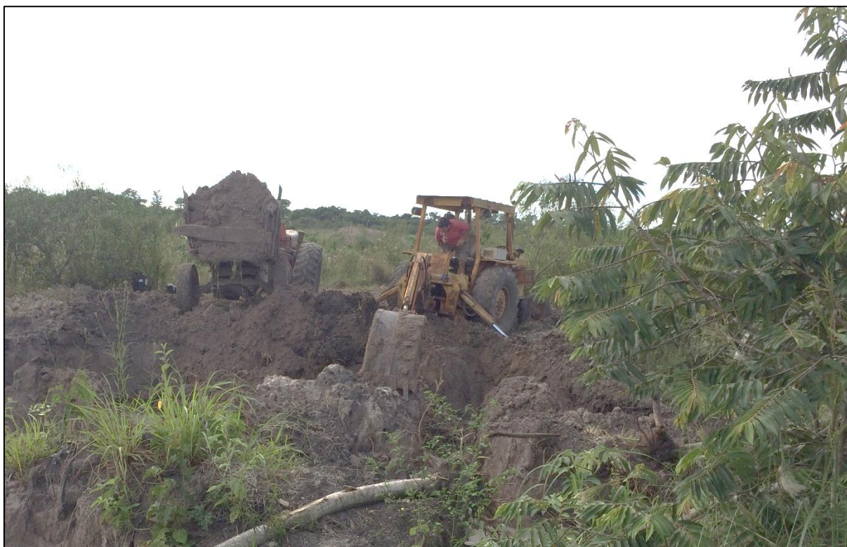
Figura 11 - Retroescavadeira carregando trator.
