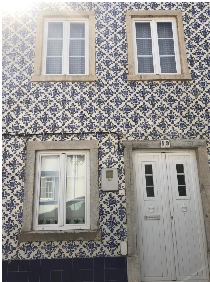
Figura 2 - Foto 2: Fachada de uma casa em Ericeira, Portugal
