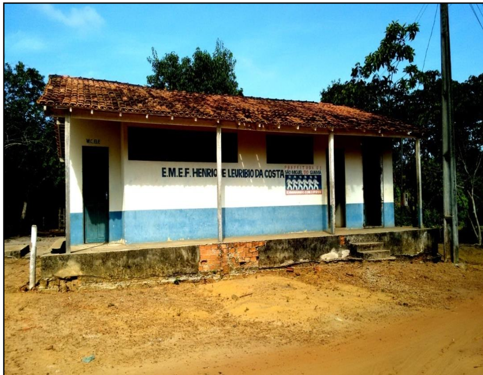
Figura 13- Escola localizada na vila Santa Ana do Muraiteua.
