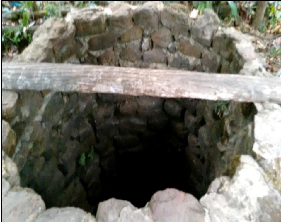
Figura 26- Poço de pedras.
