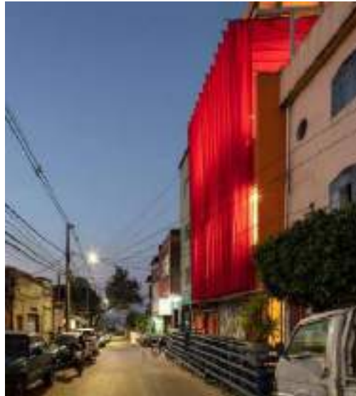
Figura 10 — Brises de tecido vermelho marcando a fachada da edificação
