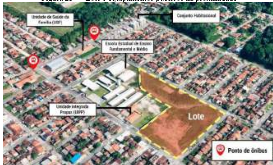
Figura 25 — Lote e equipamentos públicos na proximidade
