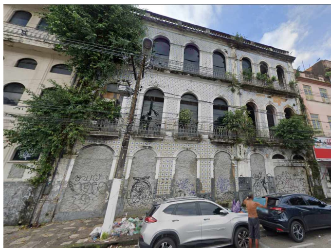
Figura 12 - Edificação abandonada na Castilhos França, Belém-PA.
